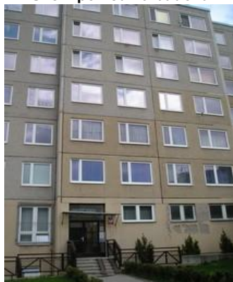
F1 Uliční pohled na budovu
